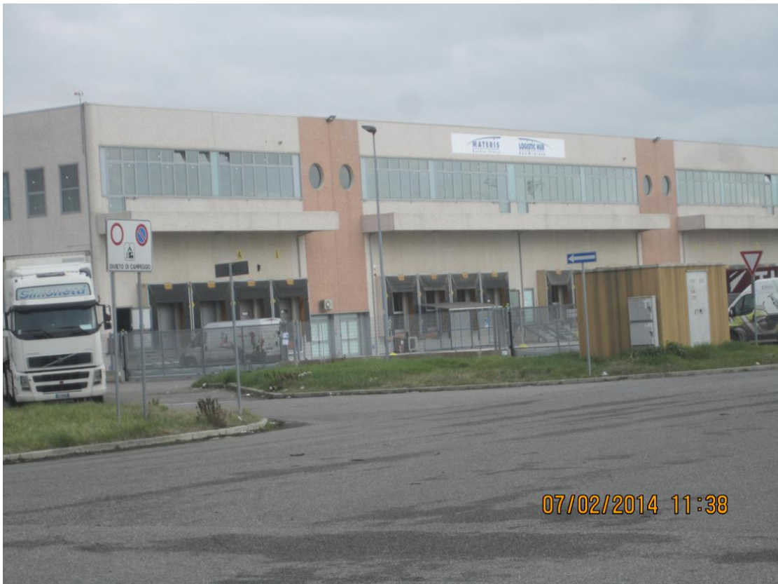
Foto n.4 - Dettaglio del prospetto di cui alla foto precedente
