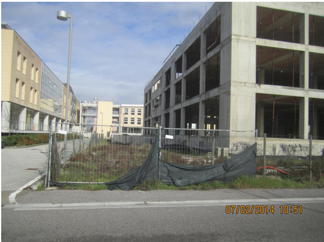
Foto n.8 – Vista da Via Marco Polo lungo la strada interna che divide i lotti 2A e 2
