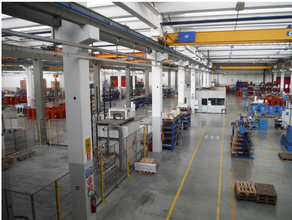
Fotografia 48. Panoramica del capannone di produzione.
