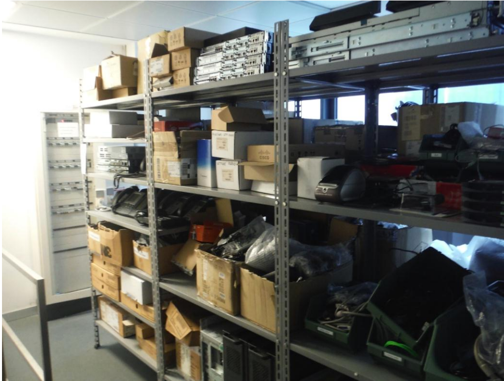
Fotografia 3. Particolare dell'anticamera del locale server.
